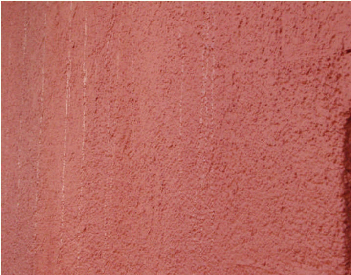
„Schnecken Spuren“ auf Dispersions Fassadenfarben
