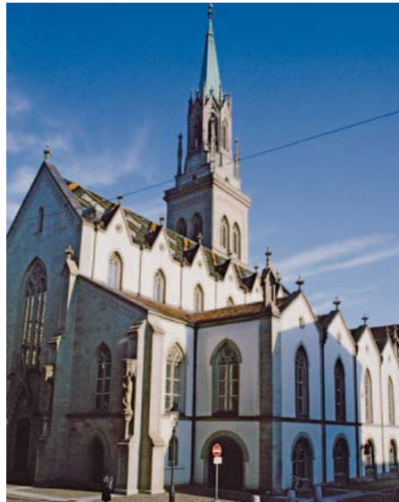
Die Kirche St. Laurenzen in St.Gallen ist 1977 mit Hydrosil-Lasur gestrichen worden.
