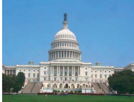
Das Capitol in Washington D.C. ist 1986 mit Exposit-Silicon-Mineralfarbe renoviert worden.
